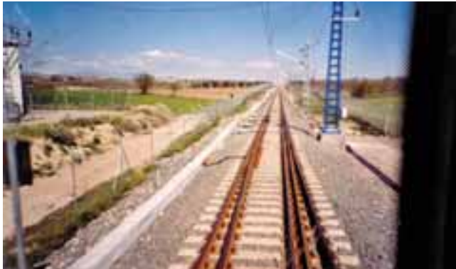
Imbrication de la voie normale dans la voie large sur la section Tardienta-Huesca
